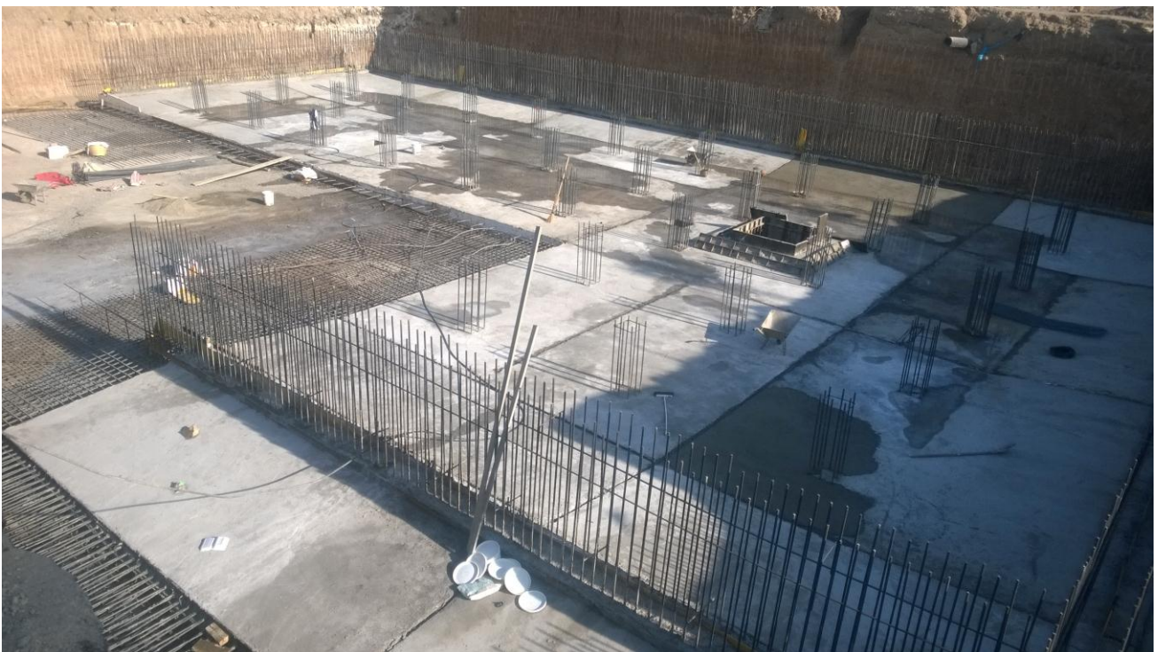
عمل آوری بتن فونداسیون
