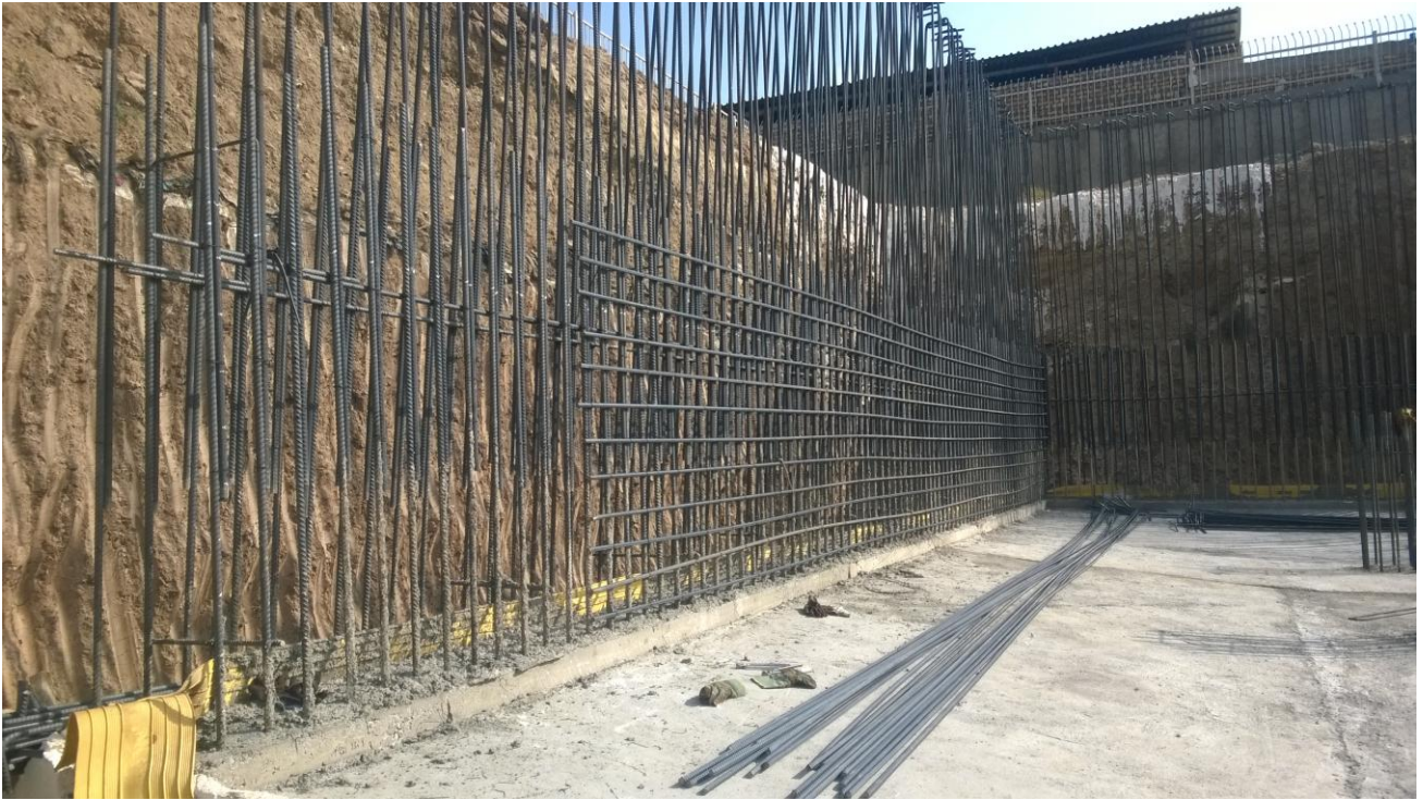
آرما توربندی دیوارها بخش اول
