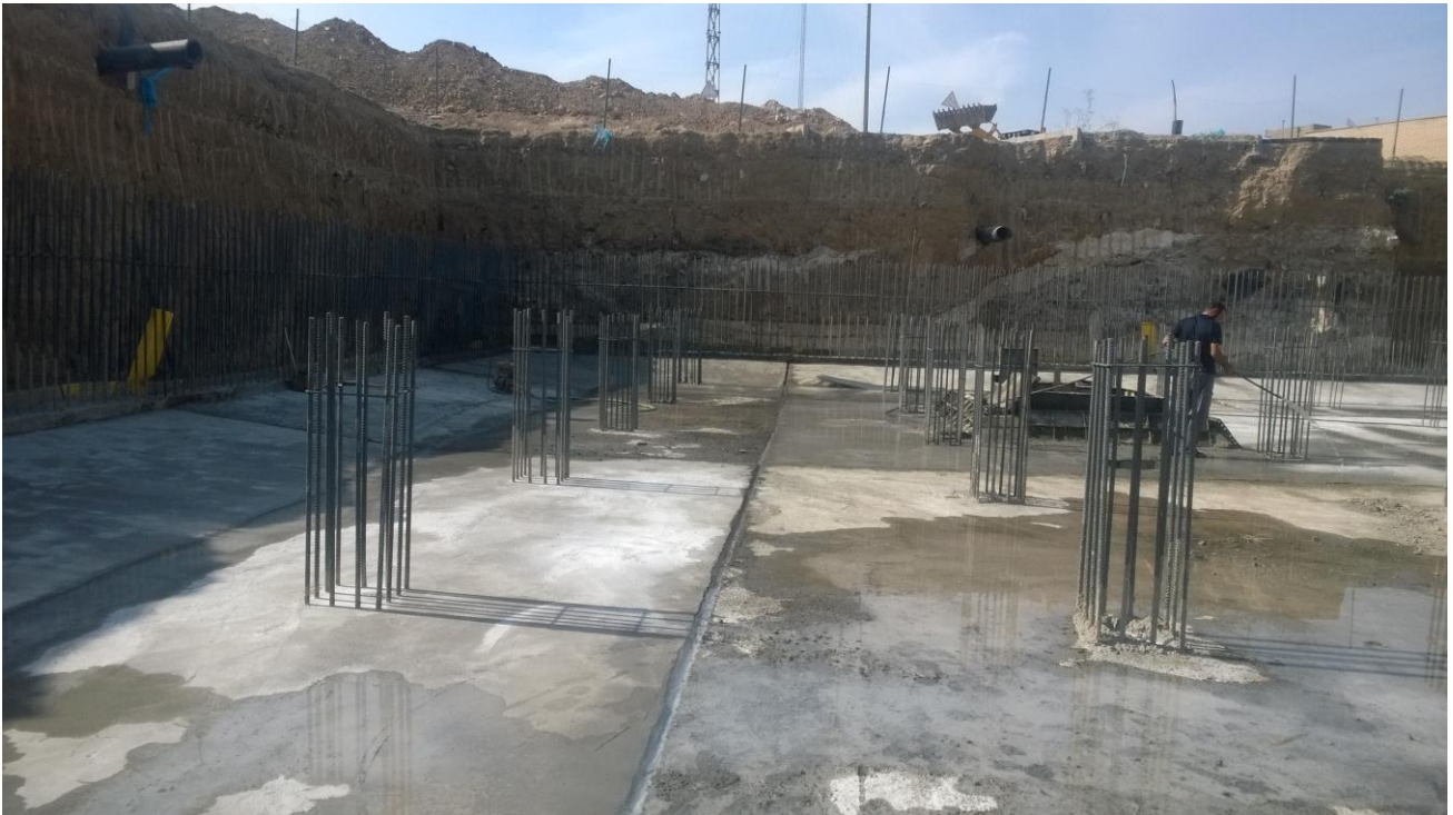
عمل آوری بتن فونداسیون
