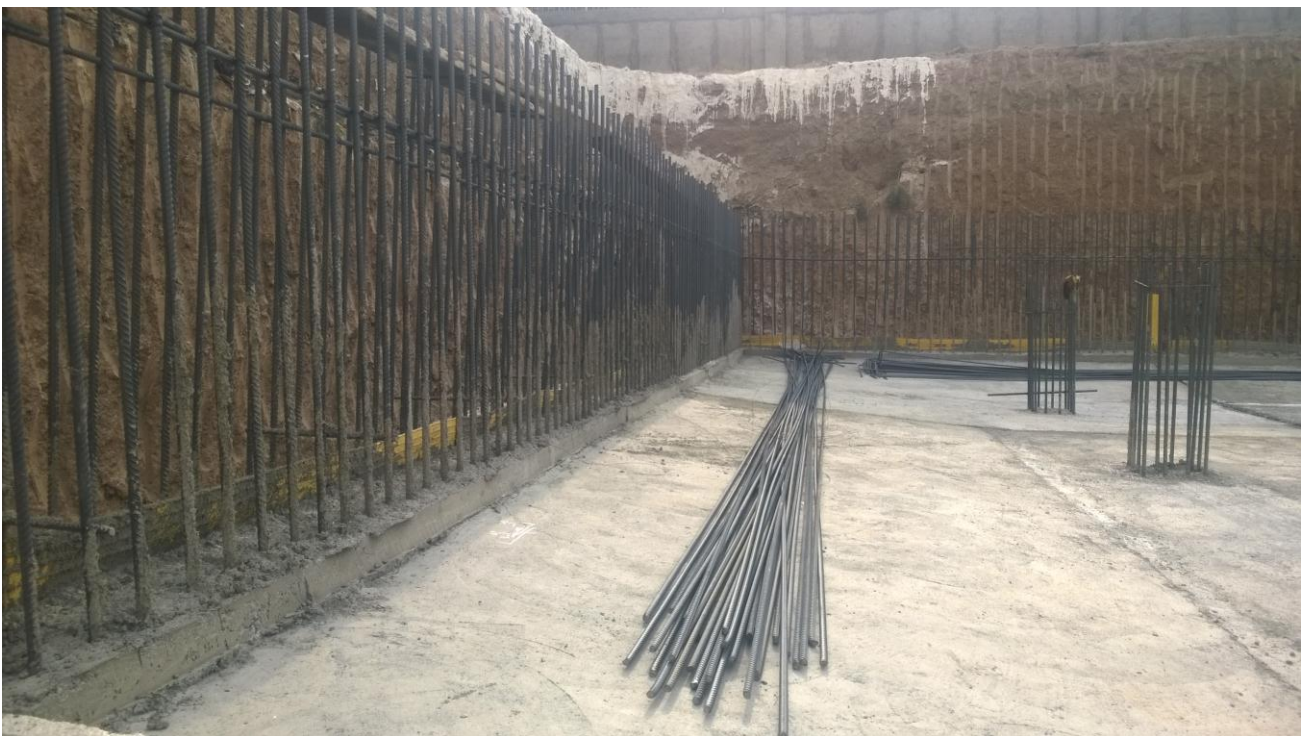
آرما توربندی دیوارها بخش اول
