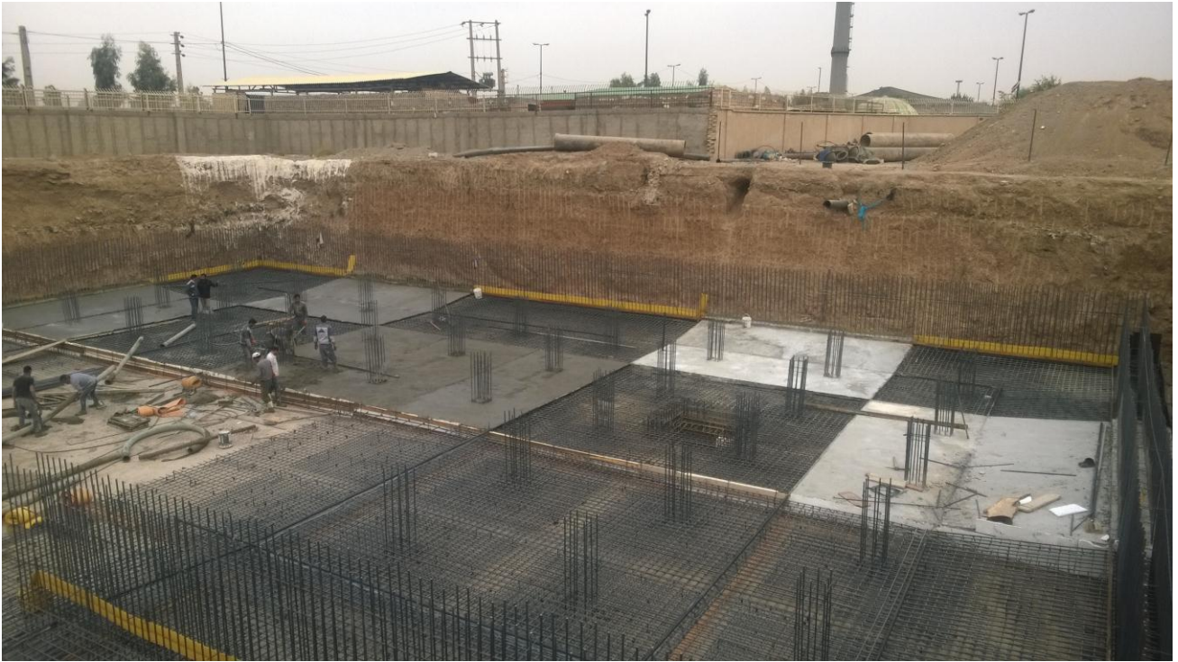
عملیات بتن ریزی بخش اول
