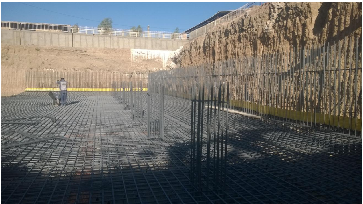
عملیات آرماتور بندی فونداسیون
