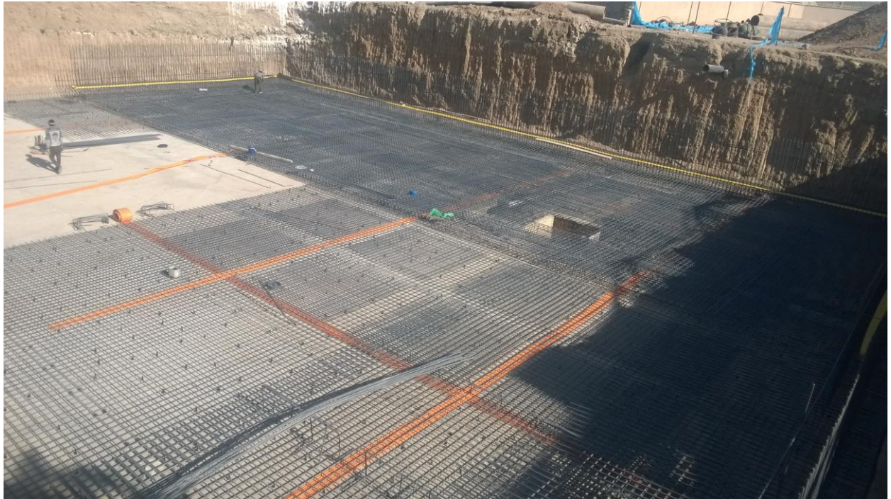
عملیات آرماتور بندی فونداسیون
