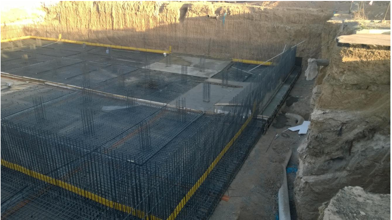
عملیات بتن ریزی بخش اول
