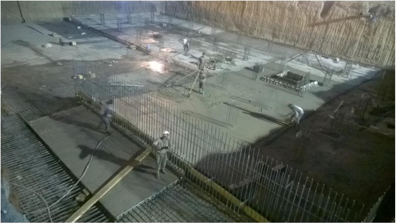
عملیات بتن ریزی بخش دوم
