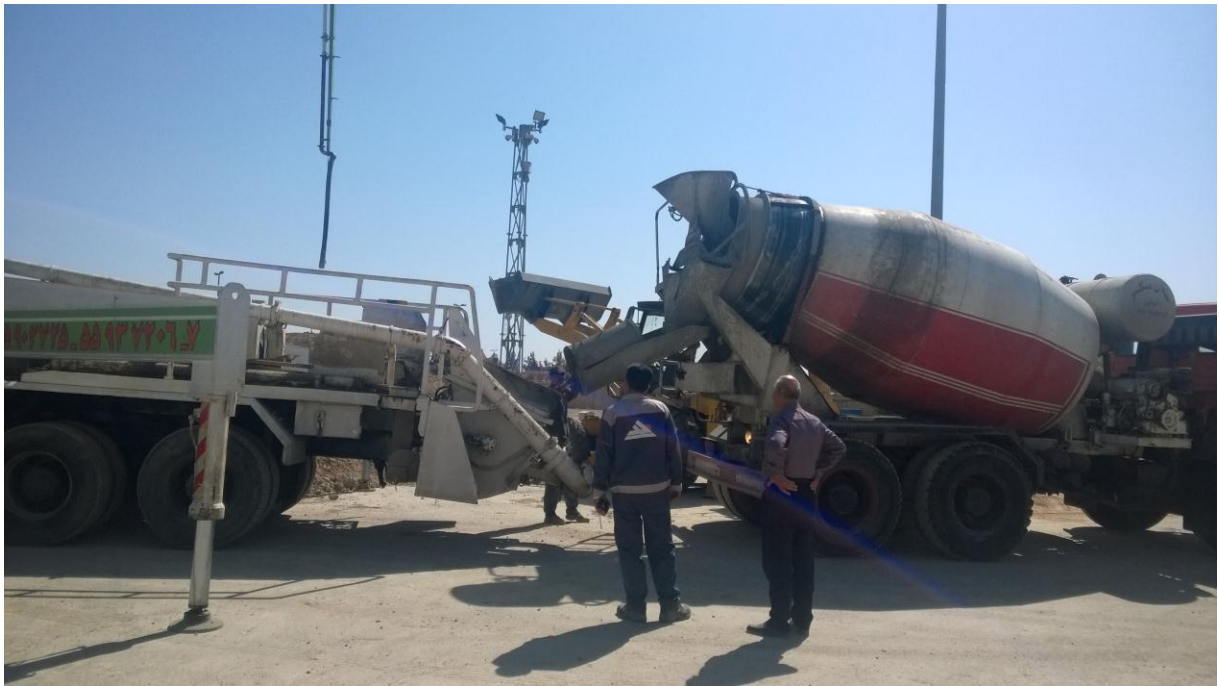
عملیات بتن ریزی بخش اول فونداسیون با پمپ زمینی
