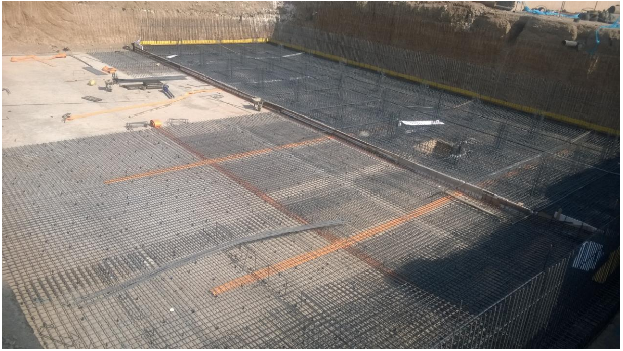
عملیات آرماتور بندی فونداسیون
