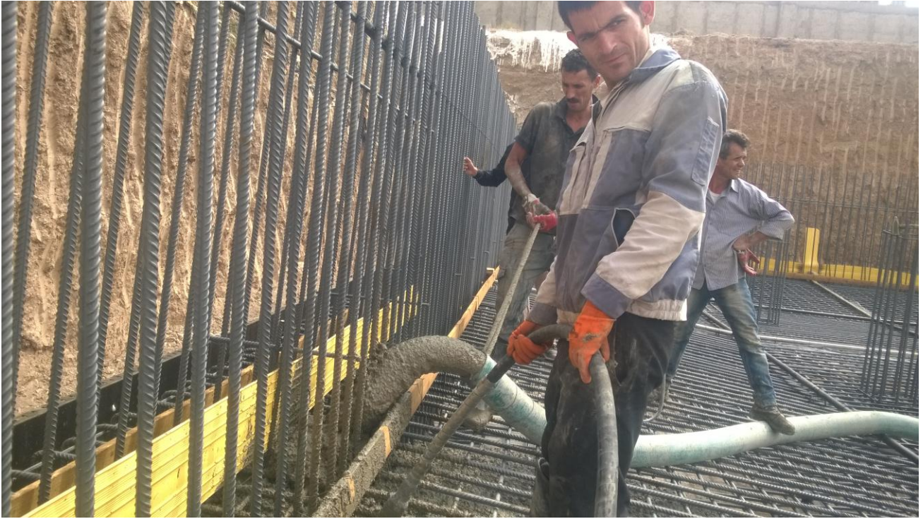
عملیات بتن ریزی بخش اول فونداسیون با پمپ زمینی
