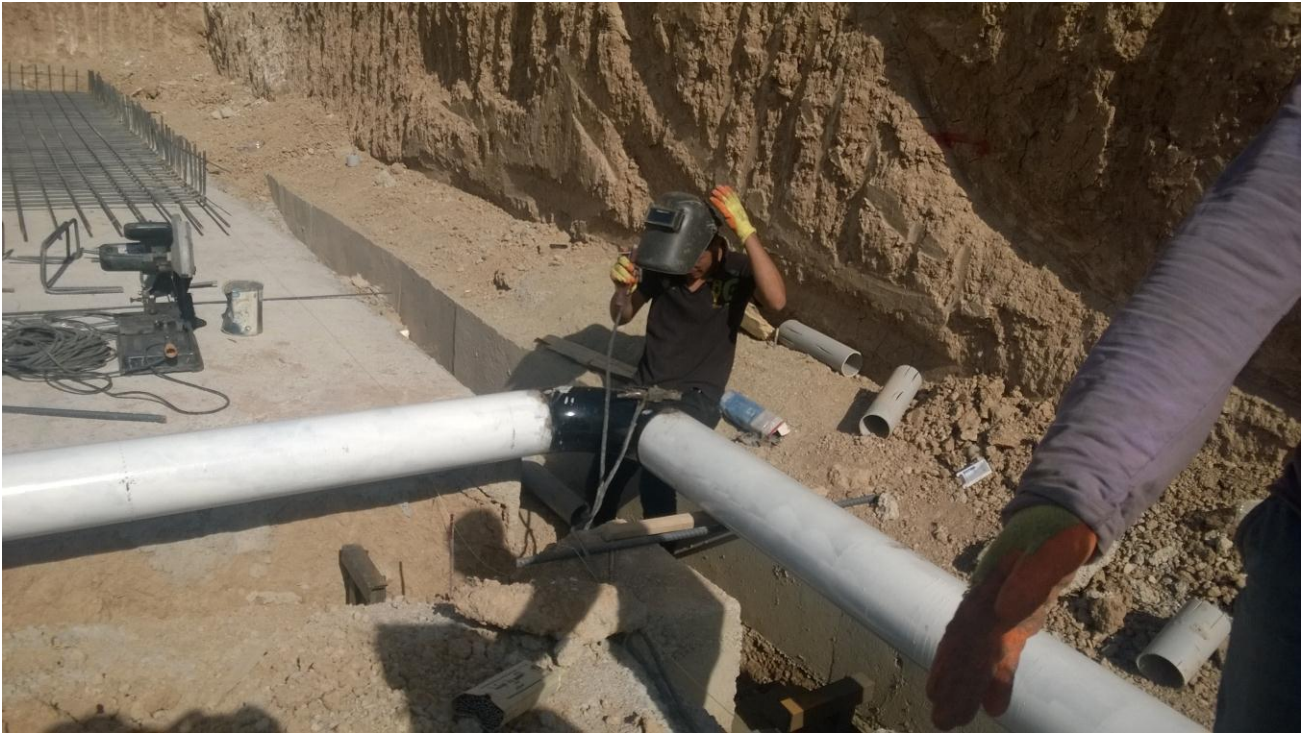
اجرای لوله های شستشو و خروجی
