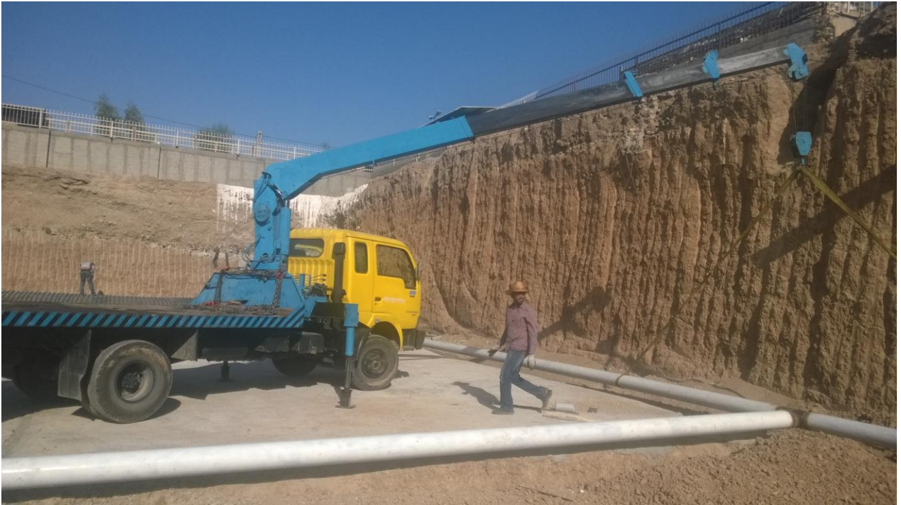
اجرای لوله های شستشو و خروجی
