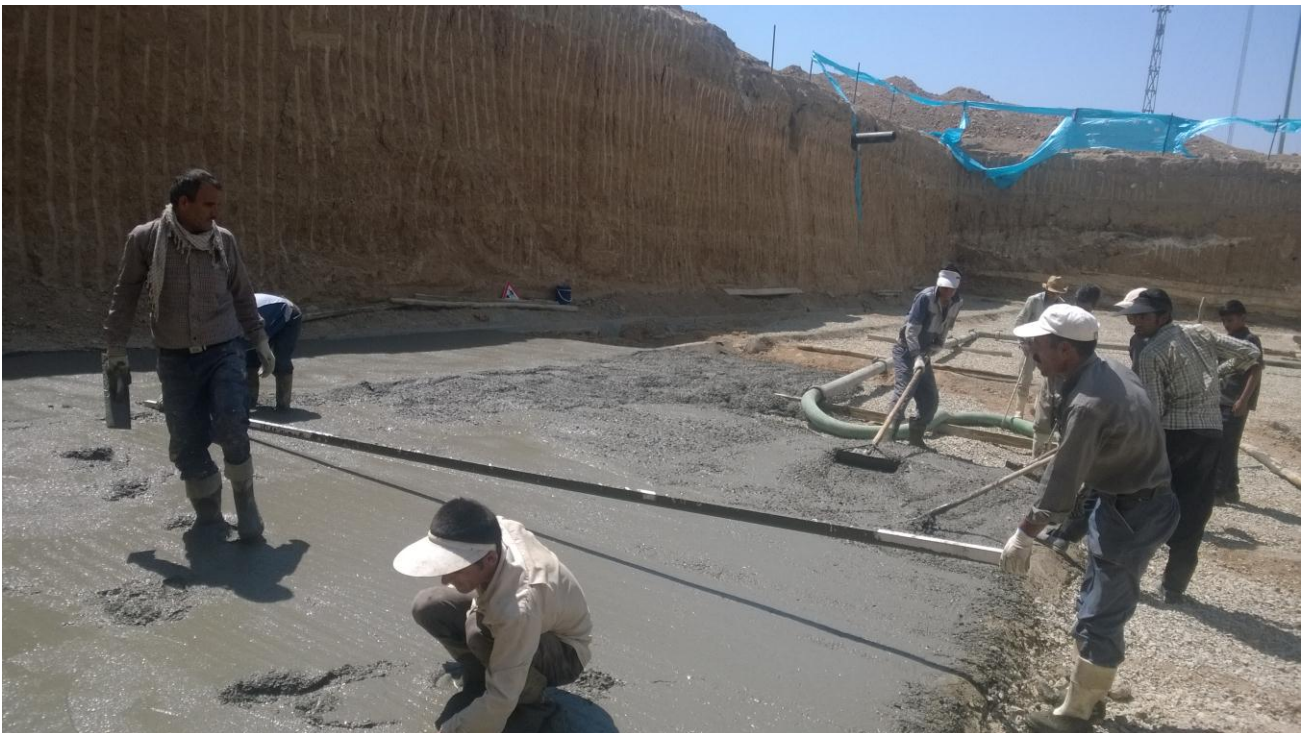
اجرای بتن مگر
