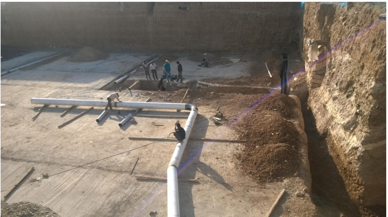
اجرای لوله های شستشو و خروجی
