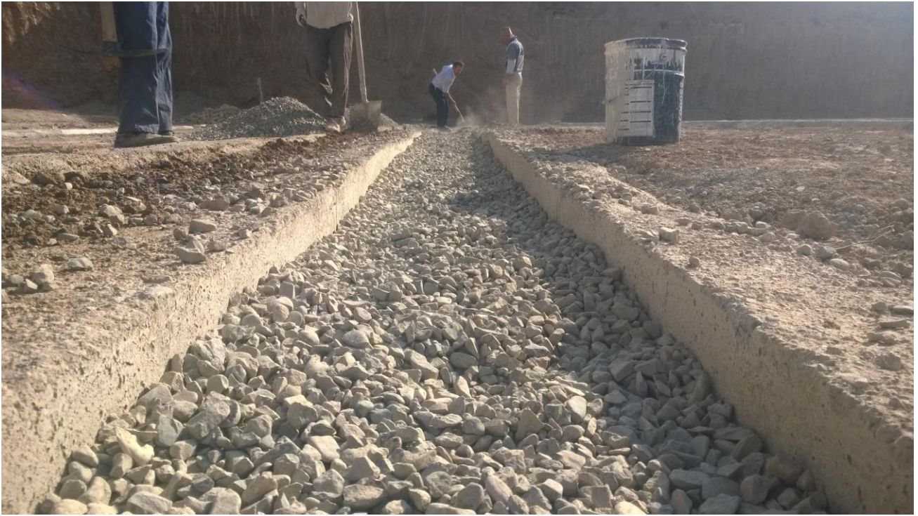
اجرای شن کانالهای زهکشی
