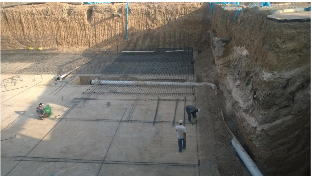
اجرای لوله های شستشو و خروجی
