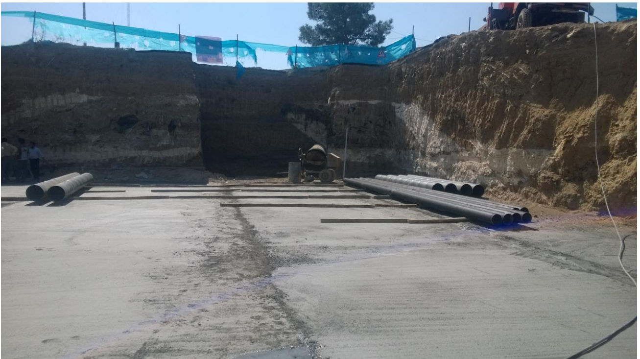
اجرای لوله های شستشو و خروجی
