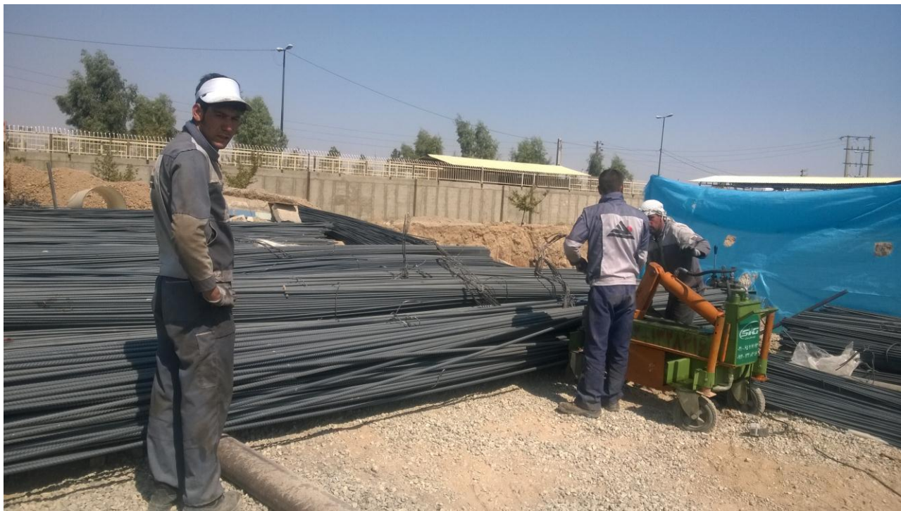
عملیات برش و خم میلگرد
