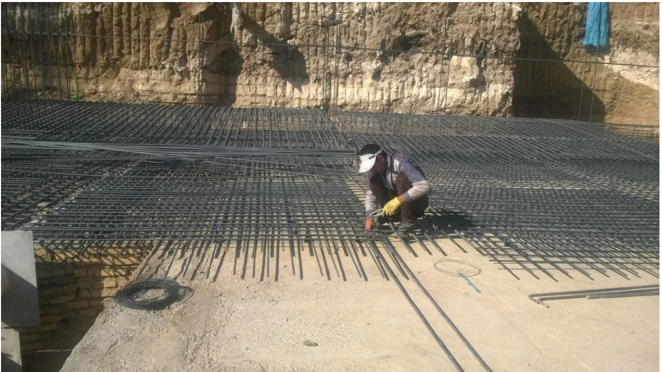
عملیات آرماتور بندی فونداسیون
