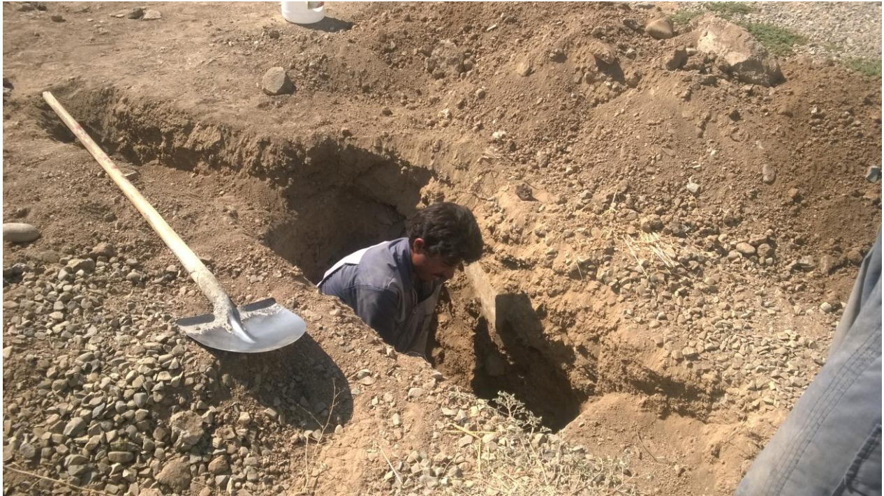
عملیات سونداژ جهت چک نمودن لول سرریز مخزن قدیم و جدید
