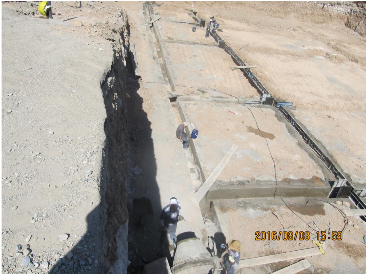
اجرای دیوار کانالهای زهکشی مخزن
