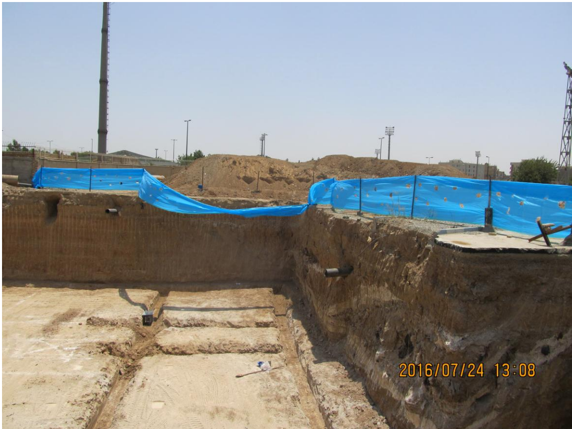
حفاری کانالهای زهکشی مخزن
