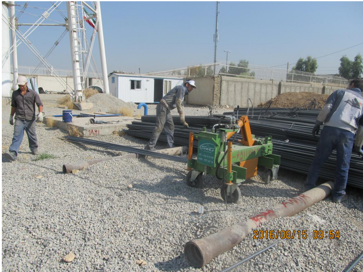
شروع عملیات خم و برش میلگرد
