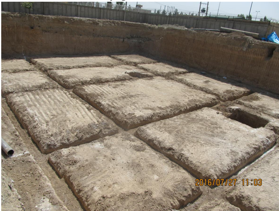
حفاری کانالهای زهکشی مخزن
