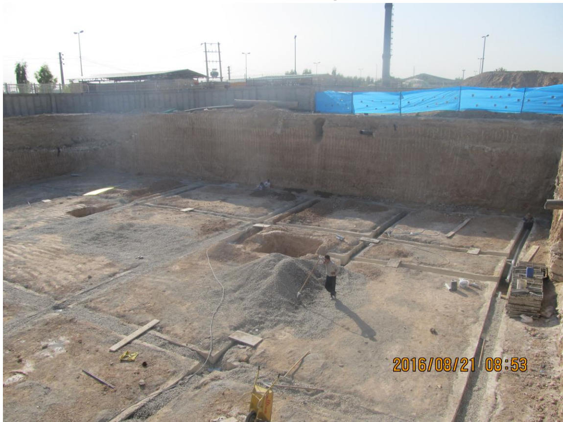
اجرای مصالح زهکشی روی کانالها
