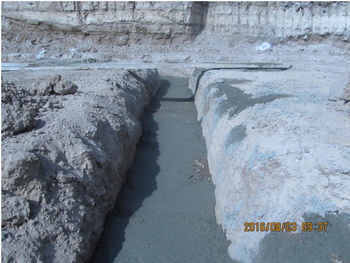
اجرای بتن مگر کف کانالهای زهکشی مخزن
