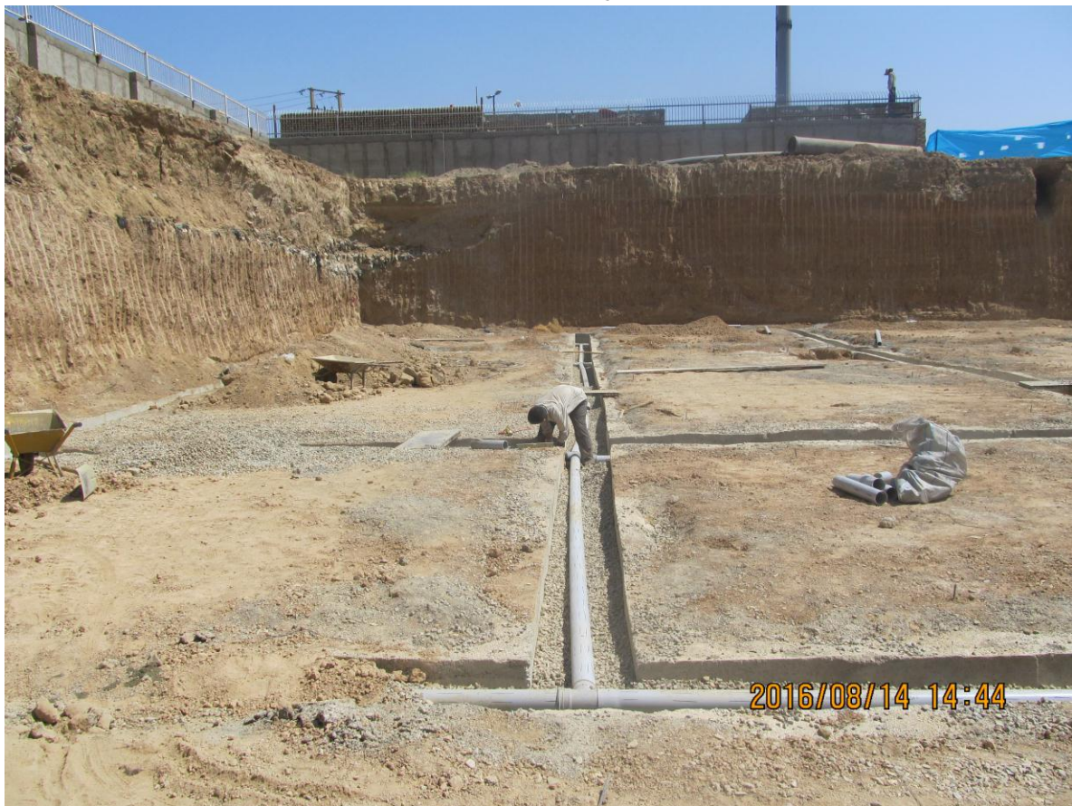
اجرای لوله های زهکشی مخزن
