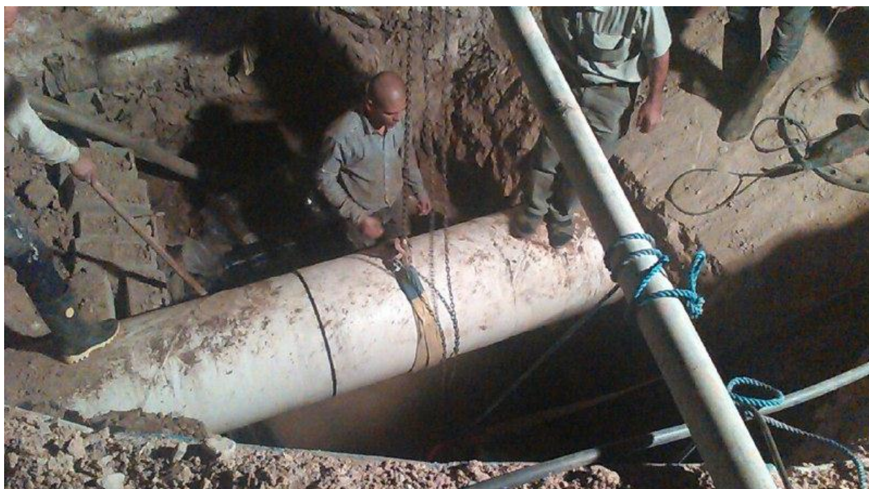
تمهیدات جهت برش لوله ۶۰۰ میلیمتری
