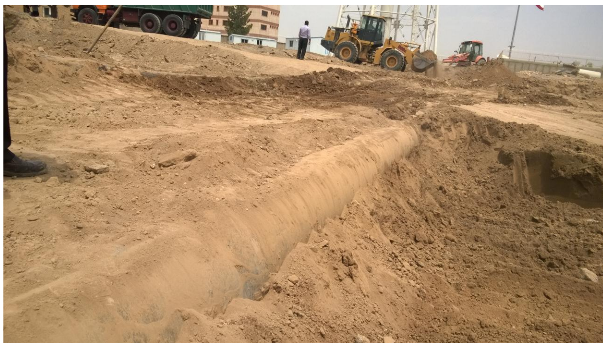
لوله ۶۰۰ میلیمتری موجود (خط لوله قبلی اتصال به شبکه آب) در محل خاکبرداری مخزن
