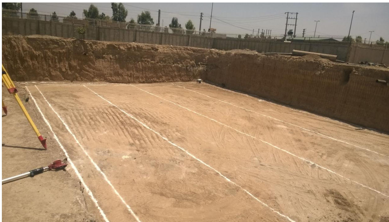
انجام عملیات نقشه برداری پس از اتمام خاکبرداری مخزن
