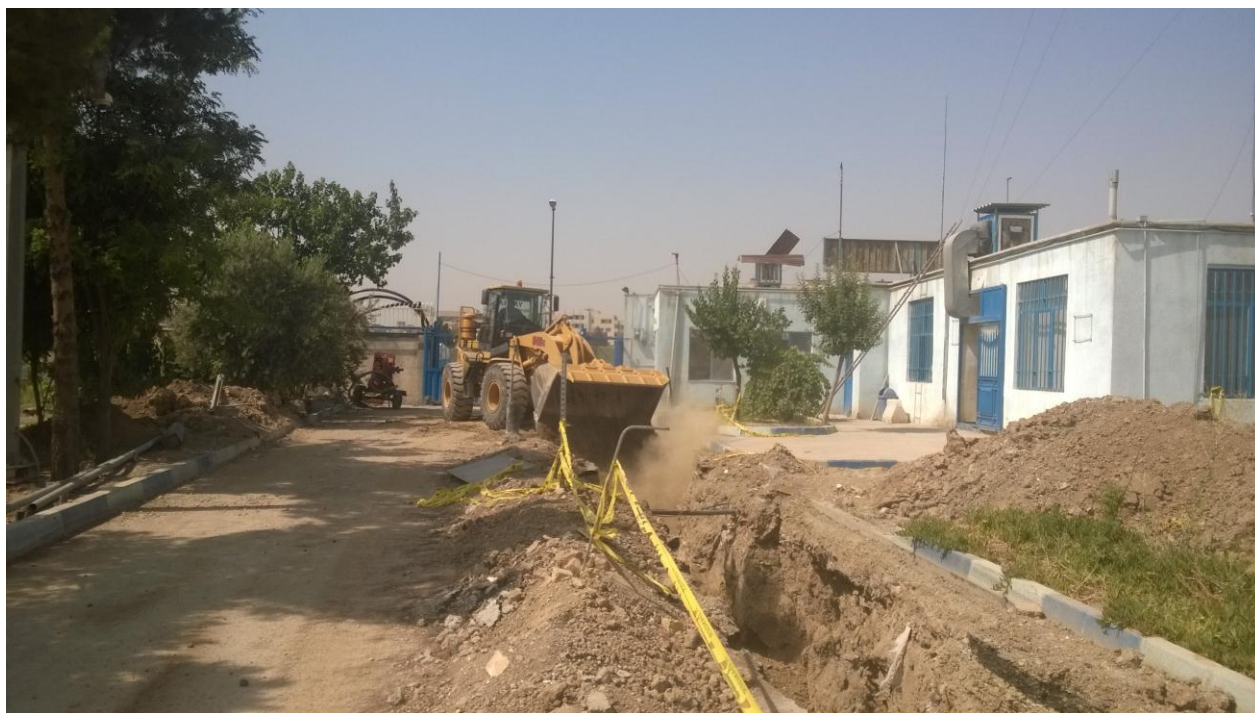
خاکریزی ترانسه لوله ۸۰۰ میلیمتری
