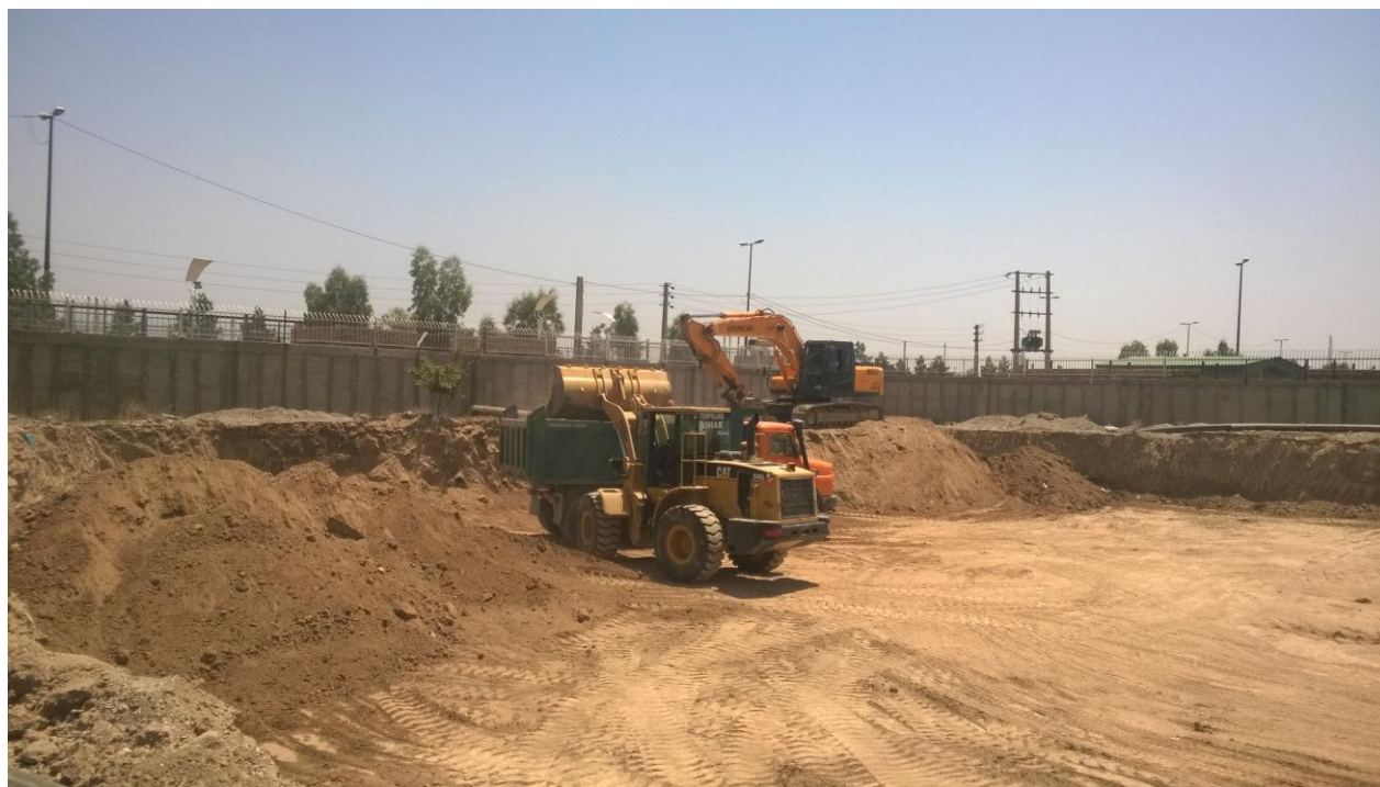
خاکبرداری مخزن موجود
