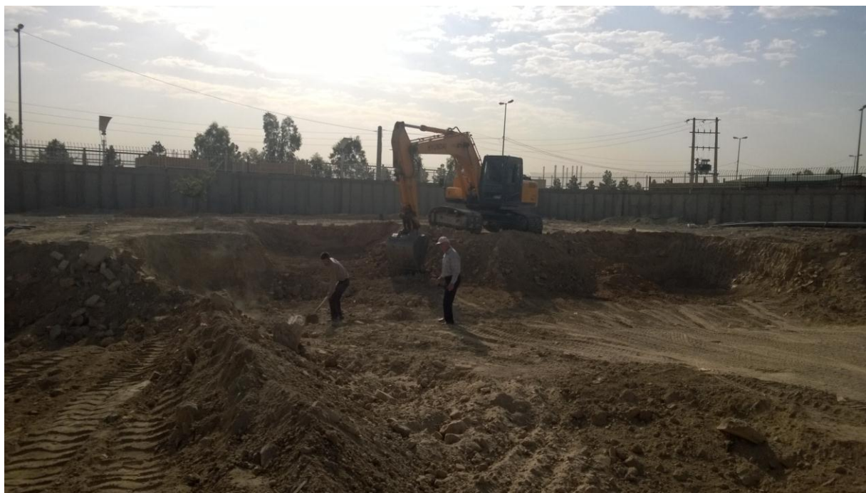
عملیات خاکبرداری مخزن
