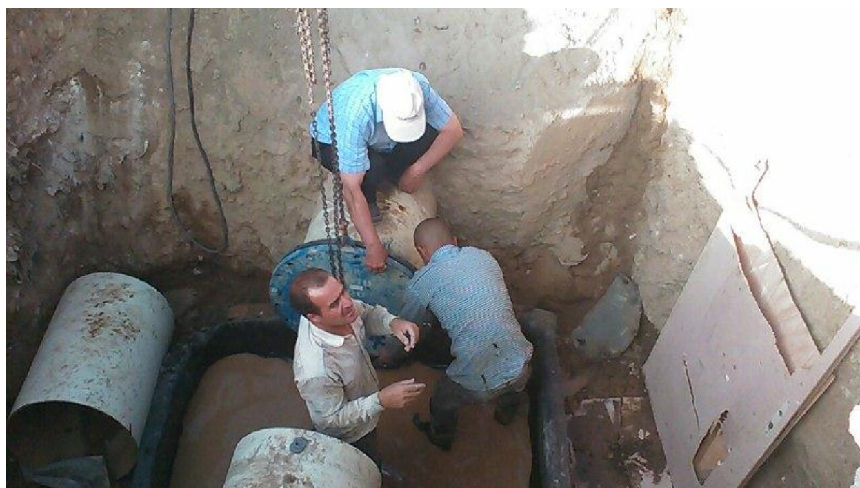
برش لوله ۶۰۰ میلیمتری و نصب فلنج کور جهت تعویض مسیر پمپاژ به شبکه
