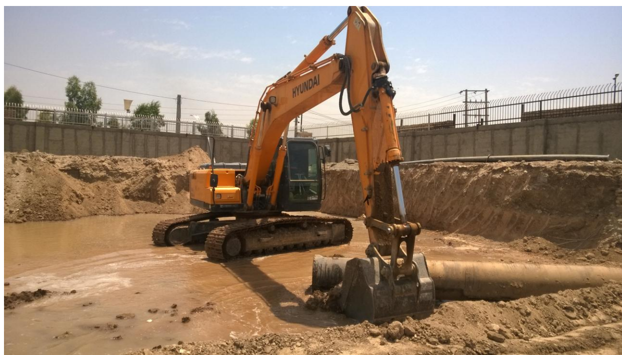
خارج نمودن لوله های موجود در محدوده مخزن
