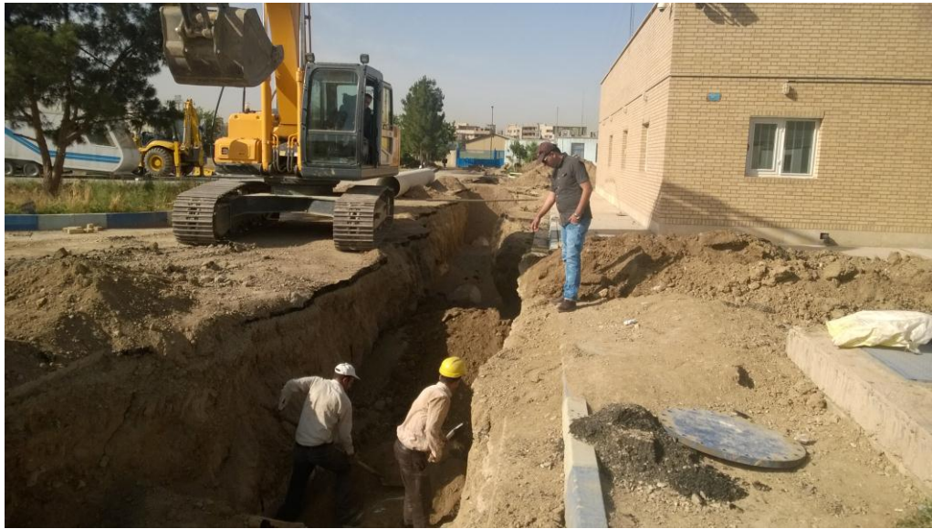
خاکریزی روی لوله ۸۰۰ میلیمتری
