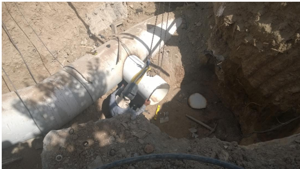
اتصال لوله ۵۰۰ به ۸۰۰ میلیمتر
