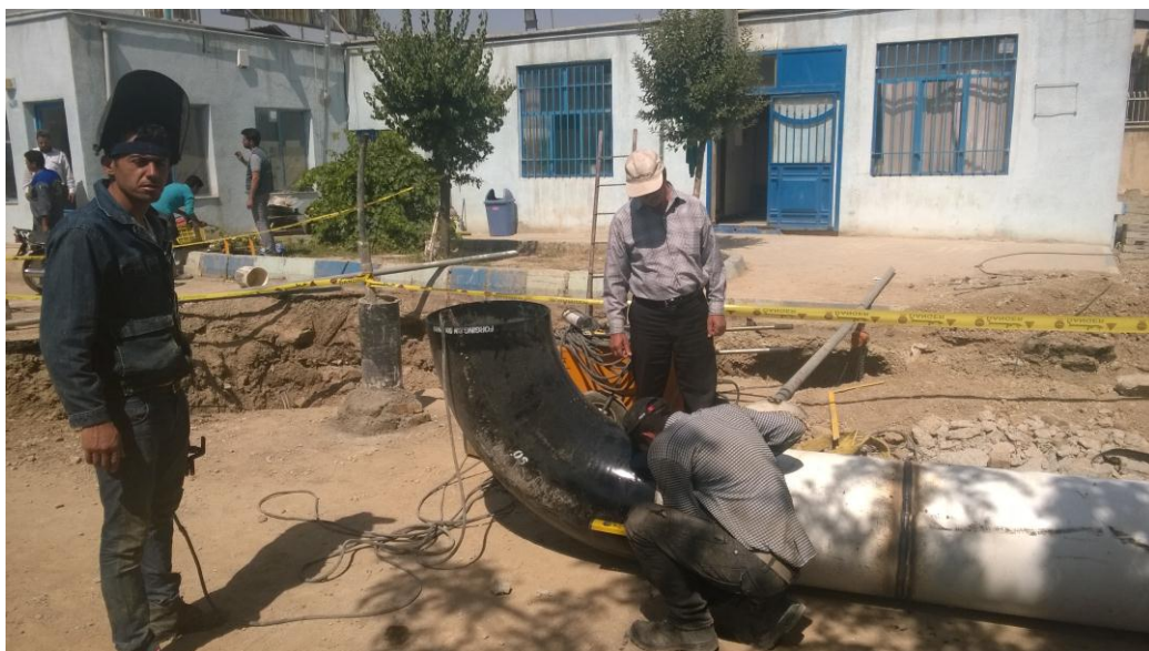
جوشکاری زانویی ۹۰ درجه فولادی (۵۰۰ میلی متری)
