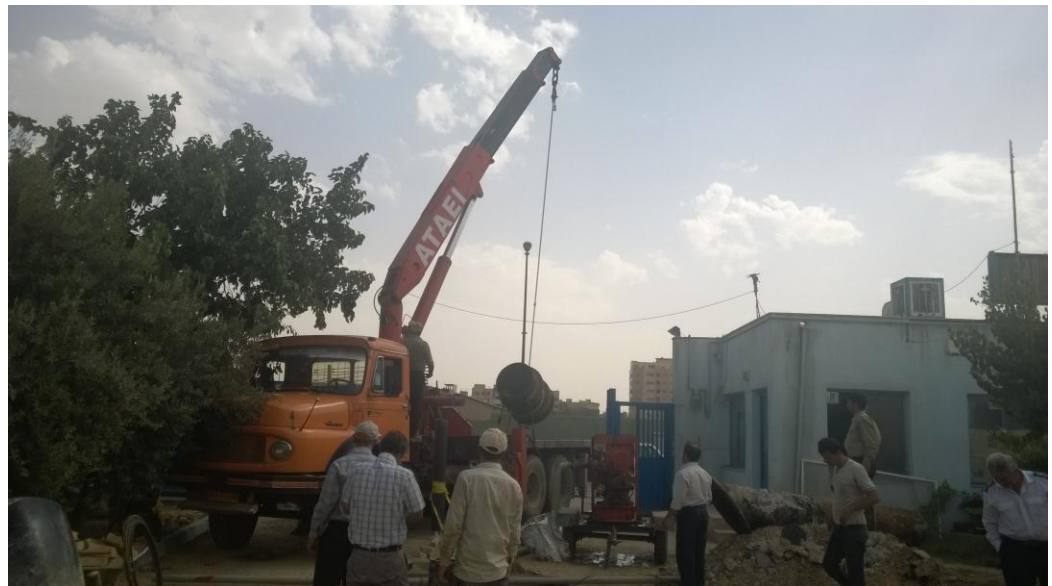
خارج نمودن کولار محل اتصال لوله ۷۰۰ میلیمتر
