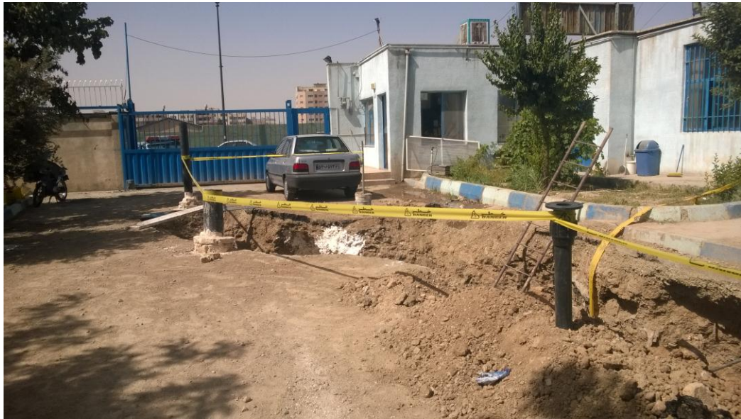
نصب نوار خطر در مسیر ترانشه
