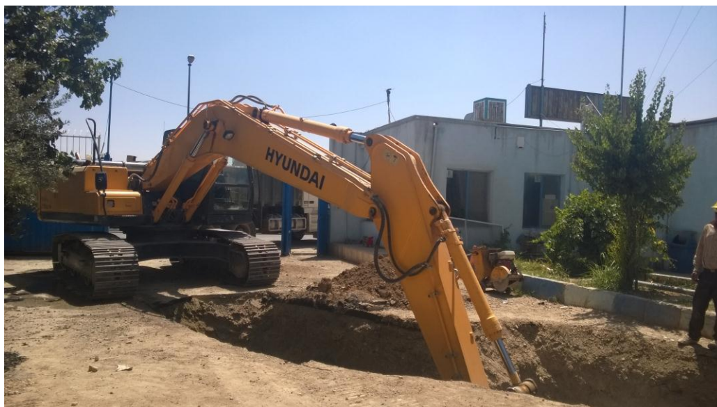
حفاری محل اتصال لوله ۵۰۰ به ۷۰۰ میلیمتر
