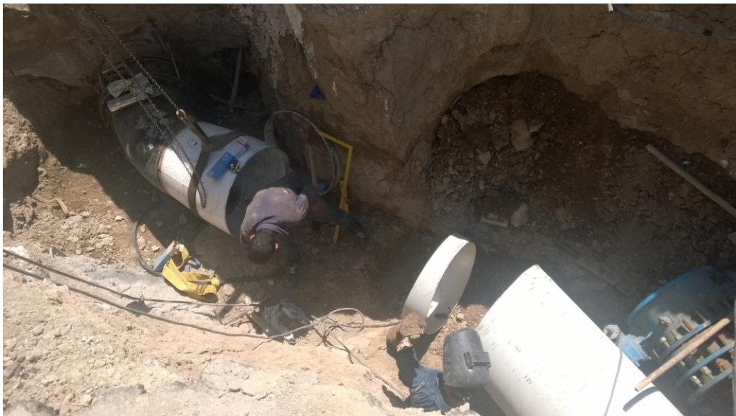
مقدمات اتصال لوله ۸۰۰ به ۷۰۰ میلیمتر
