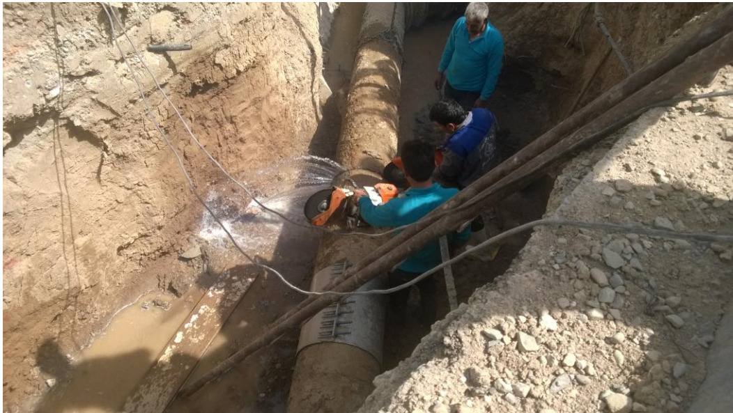
خروج پر فشار آب در هنگام برش لوله ۵۰۰ میلیمتر
