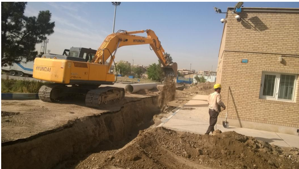
خاکریزی روی لوله ۸۰۰ میلیمتری
