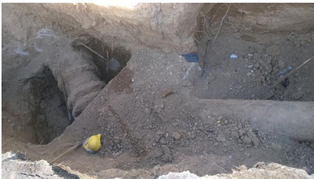
محل اتصال لوله ۵۰۰ به ۷۰۰ میلیمتر
