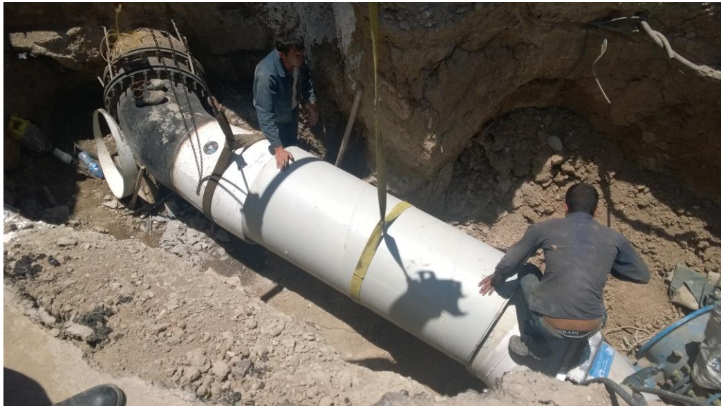
نصب قطعه ی آخر لوله ۸۰۰ میلیمتر
