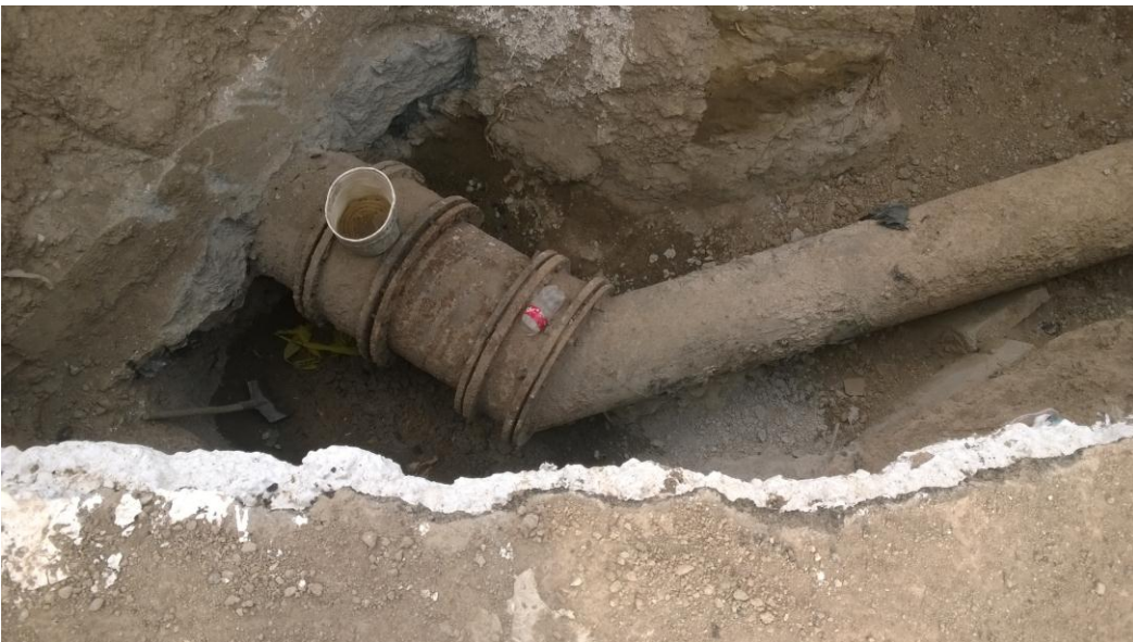
محل اتصال لوله ۵۰۰ به ۷۰۰ میلیمتر پس از تخریب بتن
