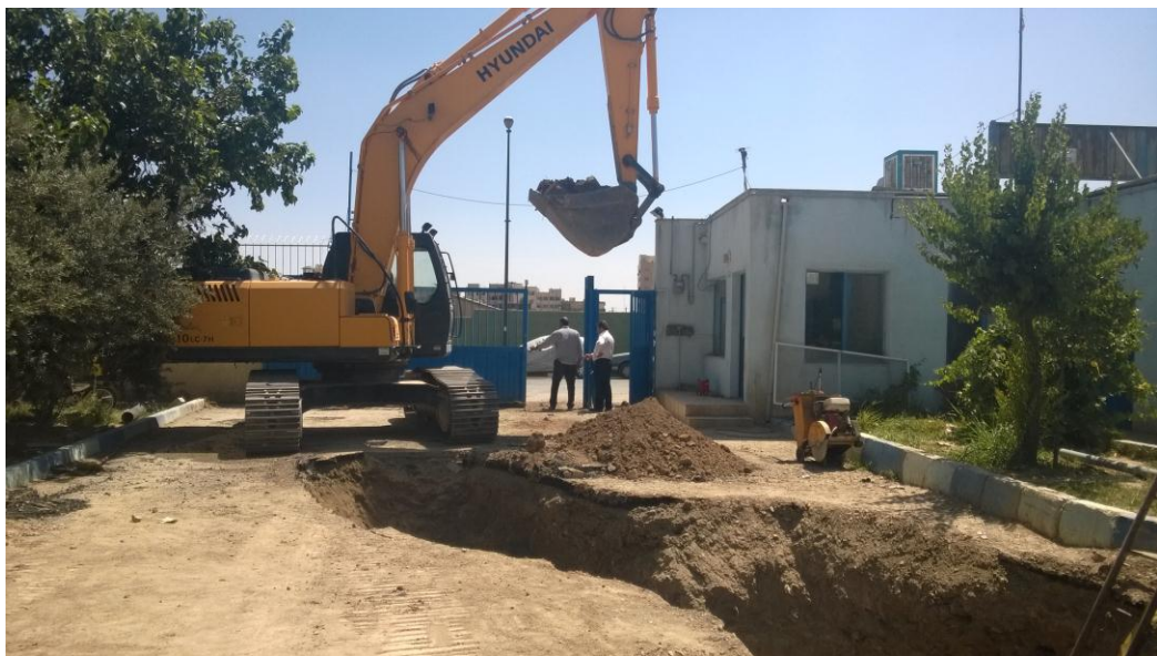
حفاری محل اتصال لوله ۵۰۰ به ۷۰۰ میلیمتر
