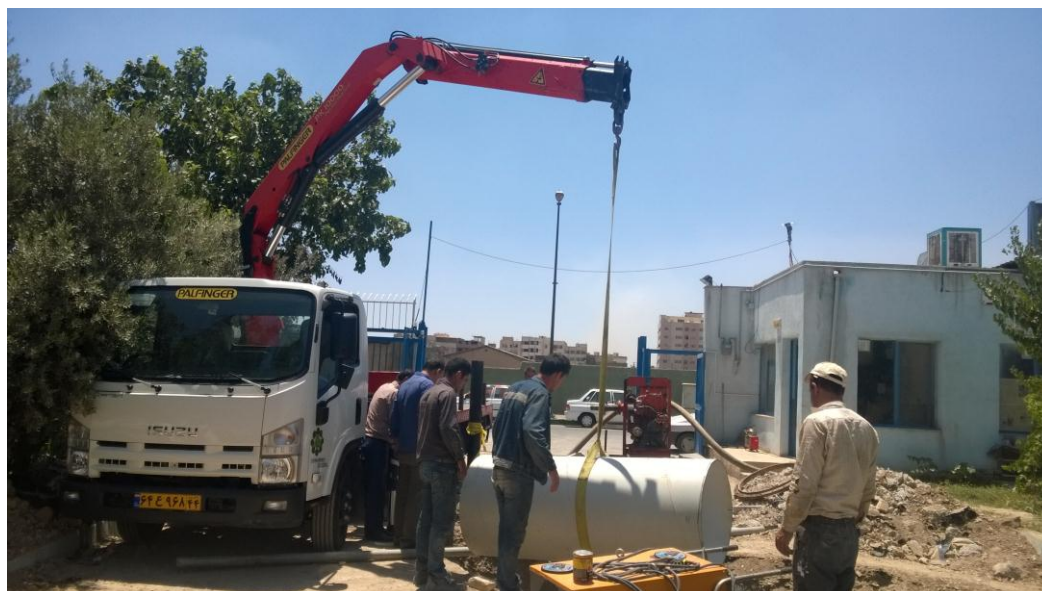
نصب قطعه ی آخر لوله ۸۰۰ میلیمتر
