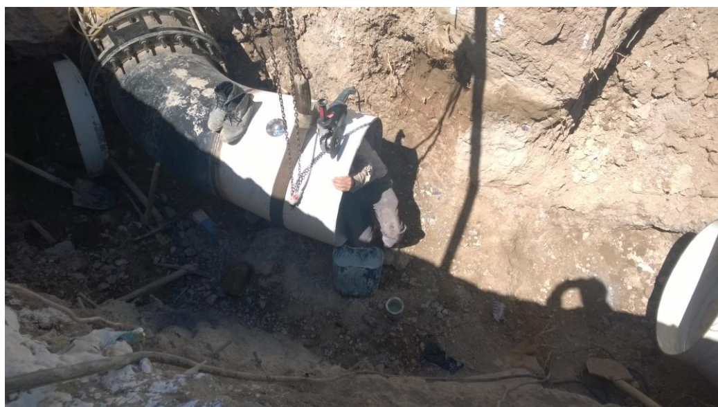
رنگ آمیزی قطعات اتصال
