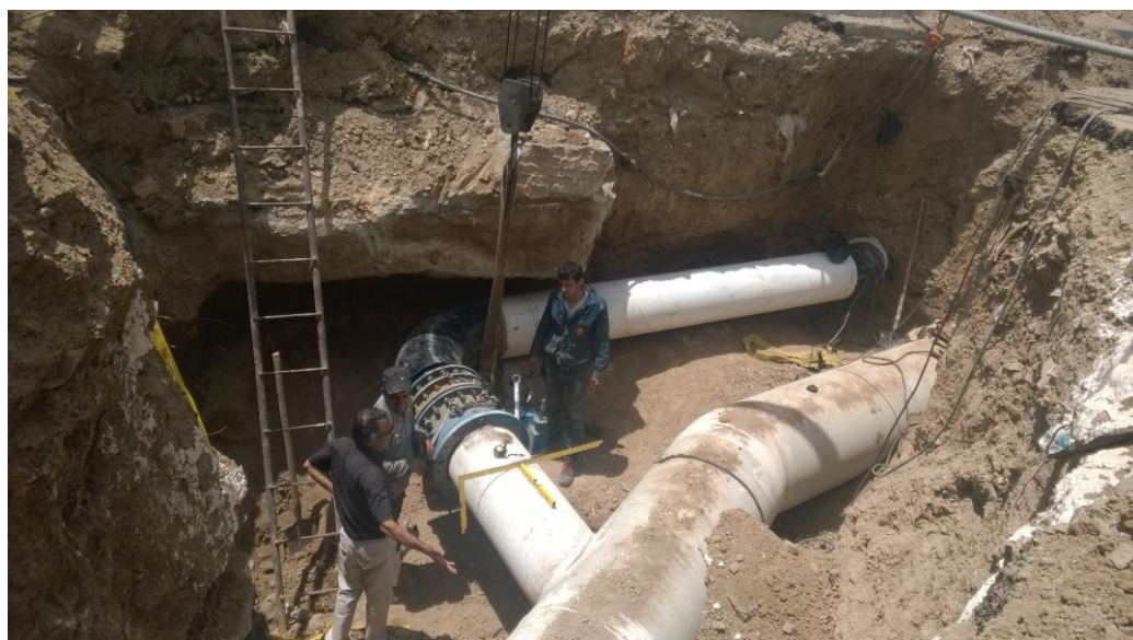
نصب شیر پروانه ای در محل اتصال لوله ۵۰۰ به ۸۰۰ میلیمتر
