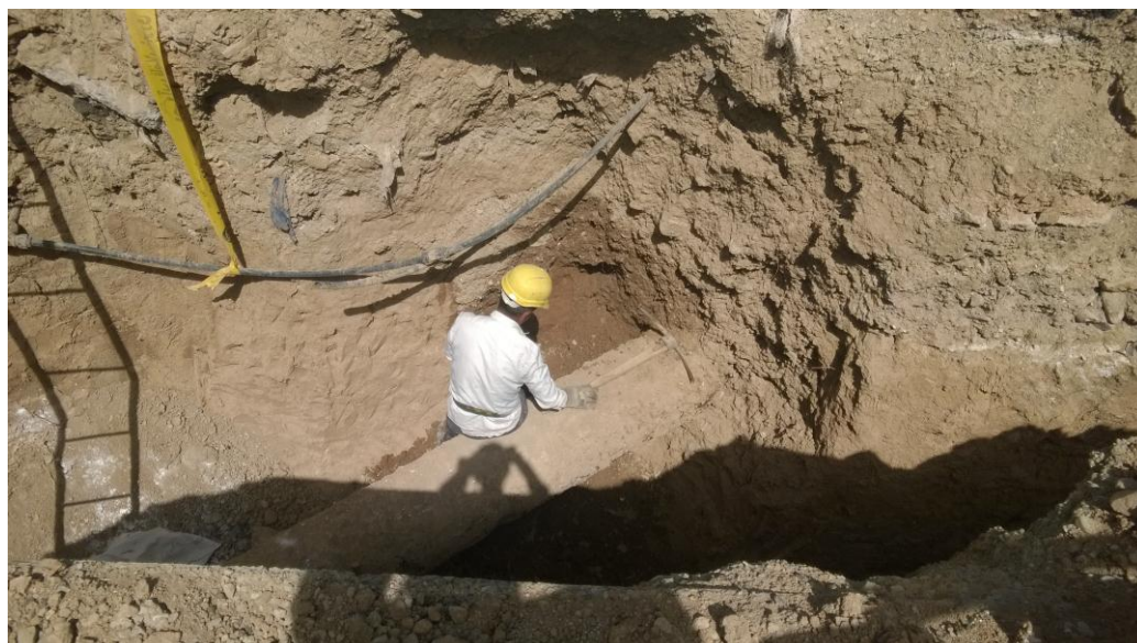
حفاری دستی محل لوله ۵۰۰ میلیمتر
