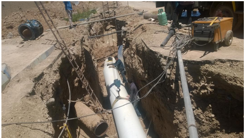
قرار دادن لوله ۸۰۰ میلیمتر در محل ترانشه
